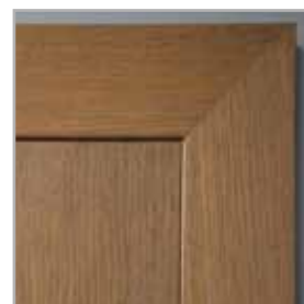
łączenie opasek pod kątem 45°
