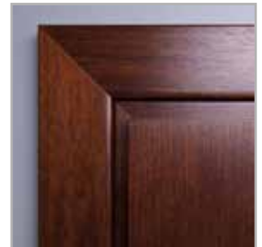
łączenie opasek pod kątem 45°
